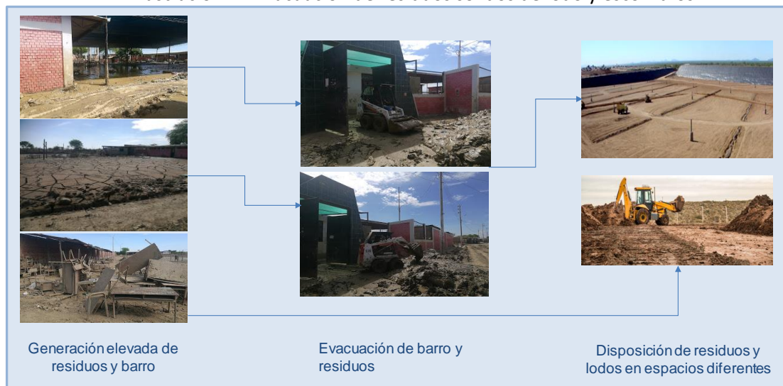
Ilustración 1.- Evacuación de residuos sólidos de lodo y escombros
